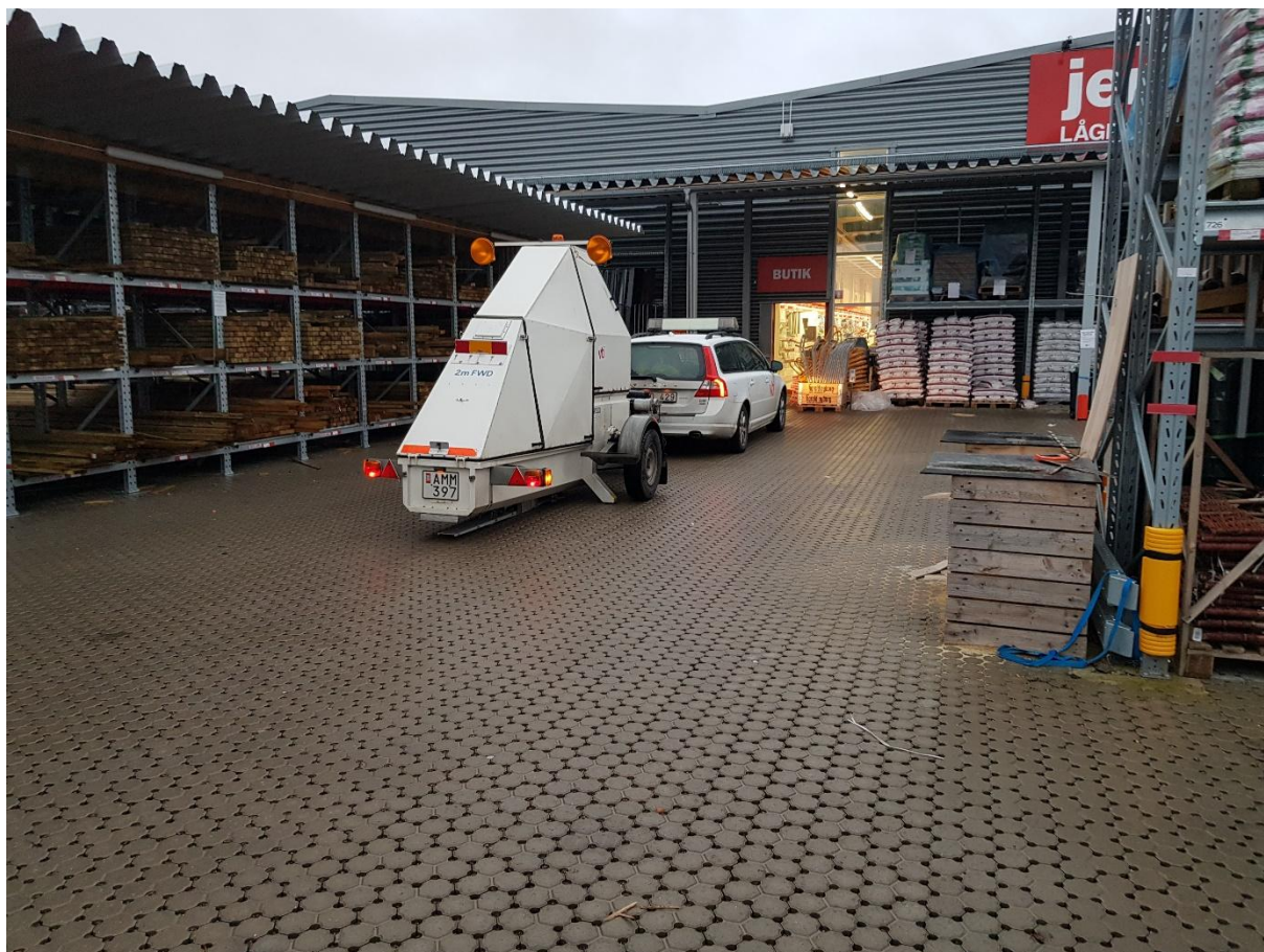
Figur 8-26. Fallviksmätning på dränerande markstensyta vid Jem & Fix i Vara (Foto Mikael Bladlund).
