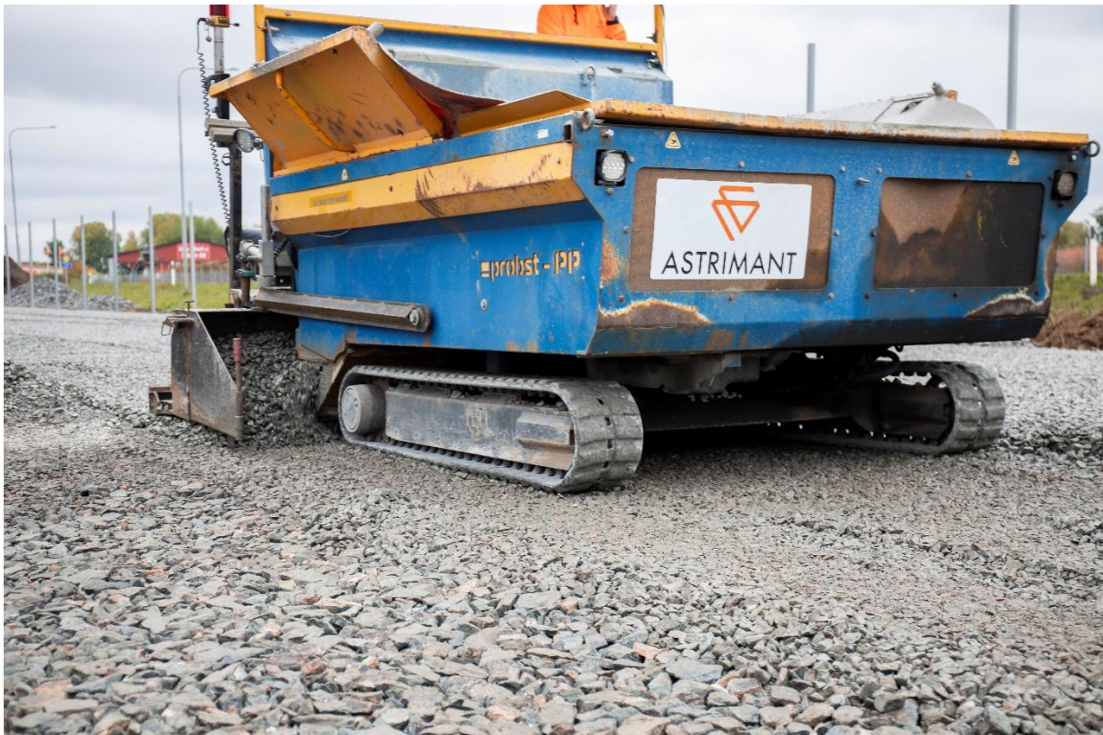
Figur 6-4 Använd helst maskiner med larvfötter. Här utläggning av öppet bärlager över öppet förstärkningslager vid Jem & Fix, Vara (Foto: Benders AB).
