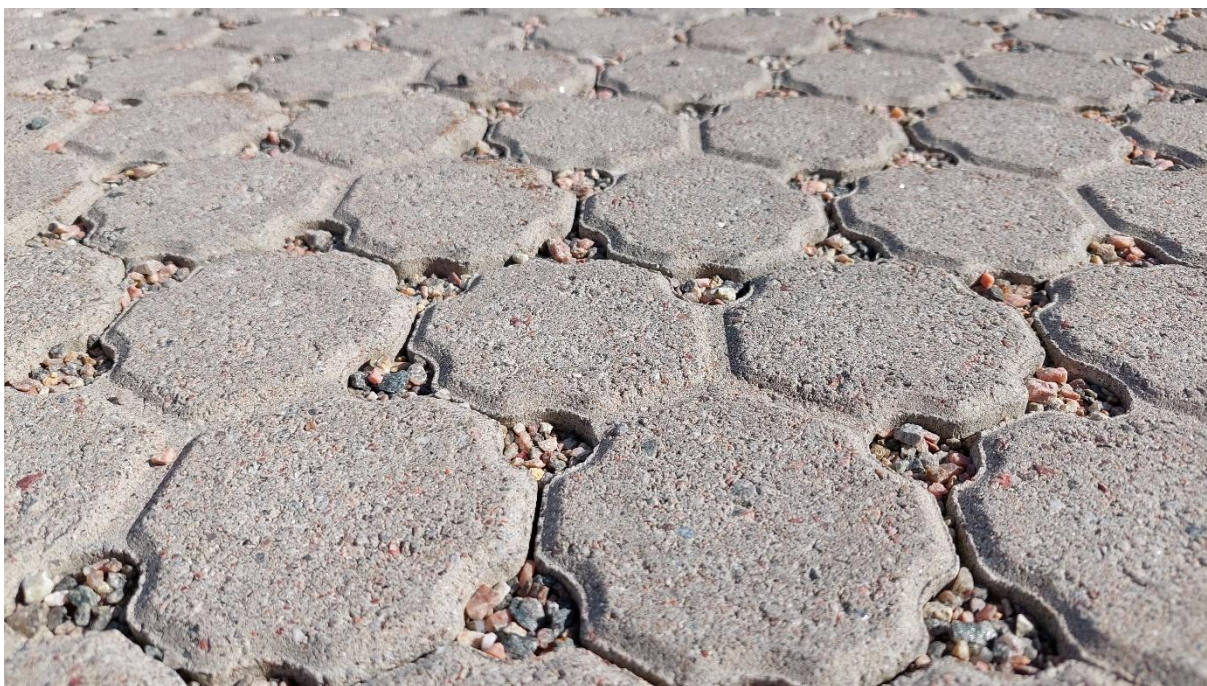
Figur 10-3 Dränerande marksten av typ Delta Drain (Benders) vid Jem & Fix i Vara (Foto Erik Simonsen).
