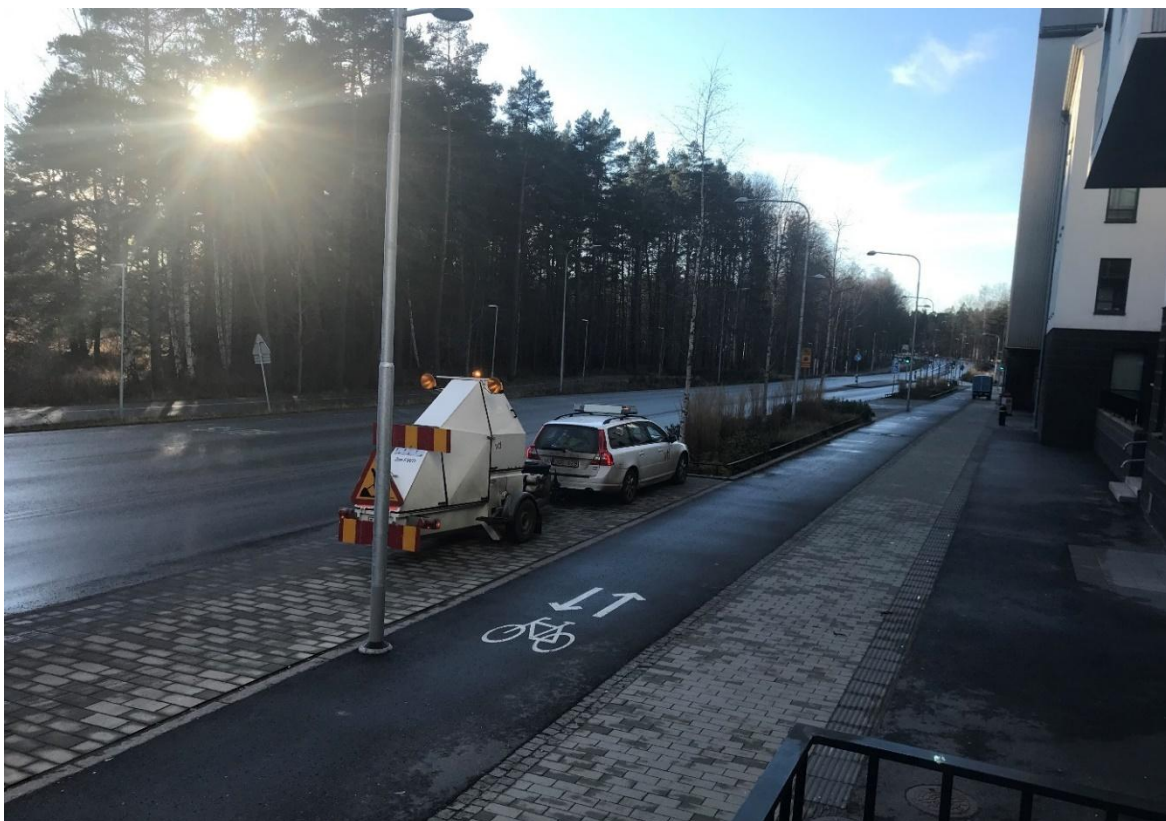
Figur 8-5. Fallviktsmätning Rosendal Etapp 1, Uppsala på Vårdsätravägen Foto Fredrik Hellman).
