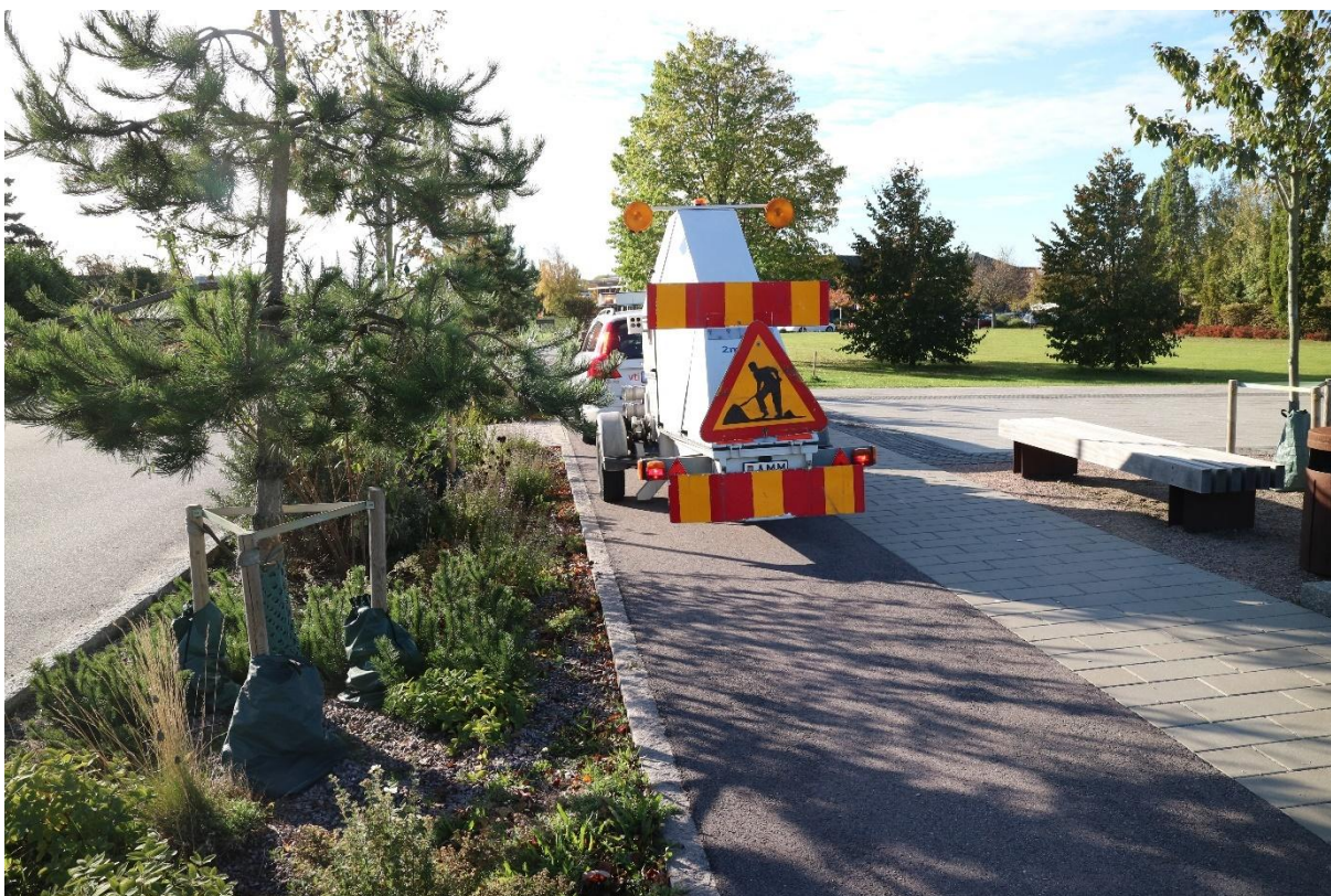
Figur 8-16. Fallviktsmätning på cykelväg med öppet förstärkningslager i anslutning till växtbädd (Foto Fredrik Hellman).
