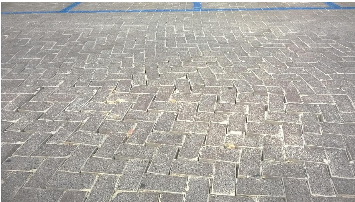
Figur 6-3 Exempel från bussgata utan inspänning. Förlust av fogmaterial har inte åtgärdats och fogförskjutning uppstår (Foto Erik Simonsen).
