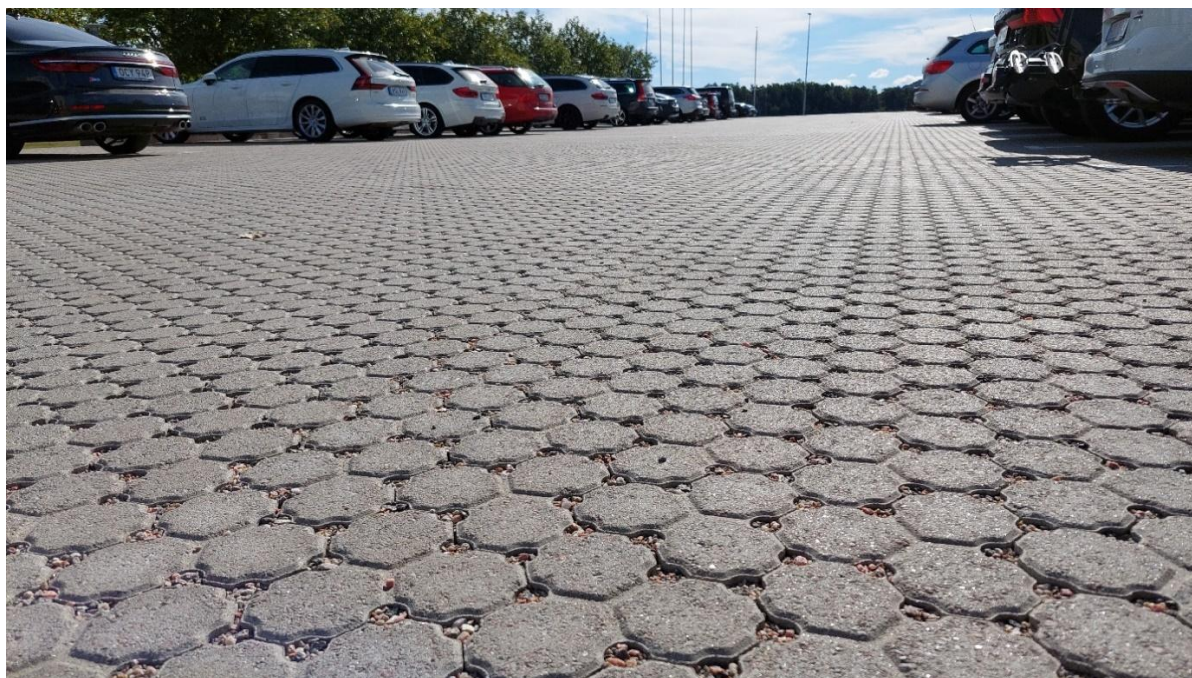
Figur 2-2 Dränerande markstensbeläggning (Delta Drain) med ca 13 procent area tillgänglig för infiltration (Foto Erik Simonsen).
