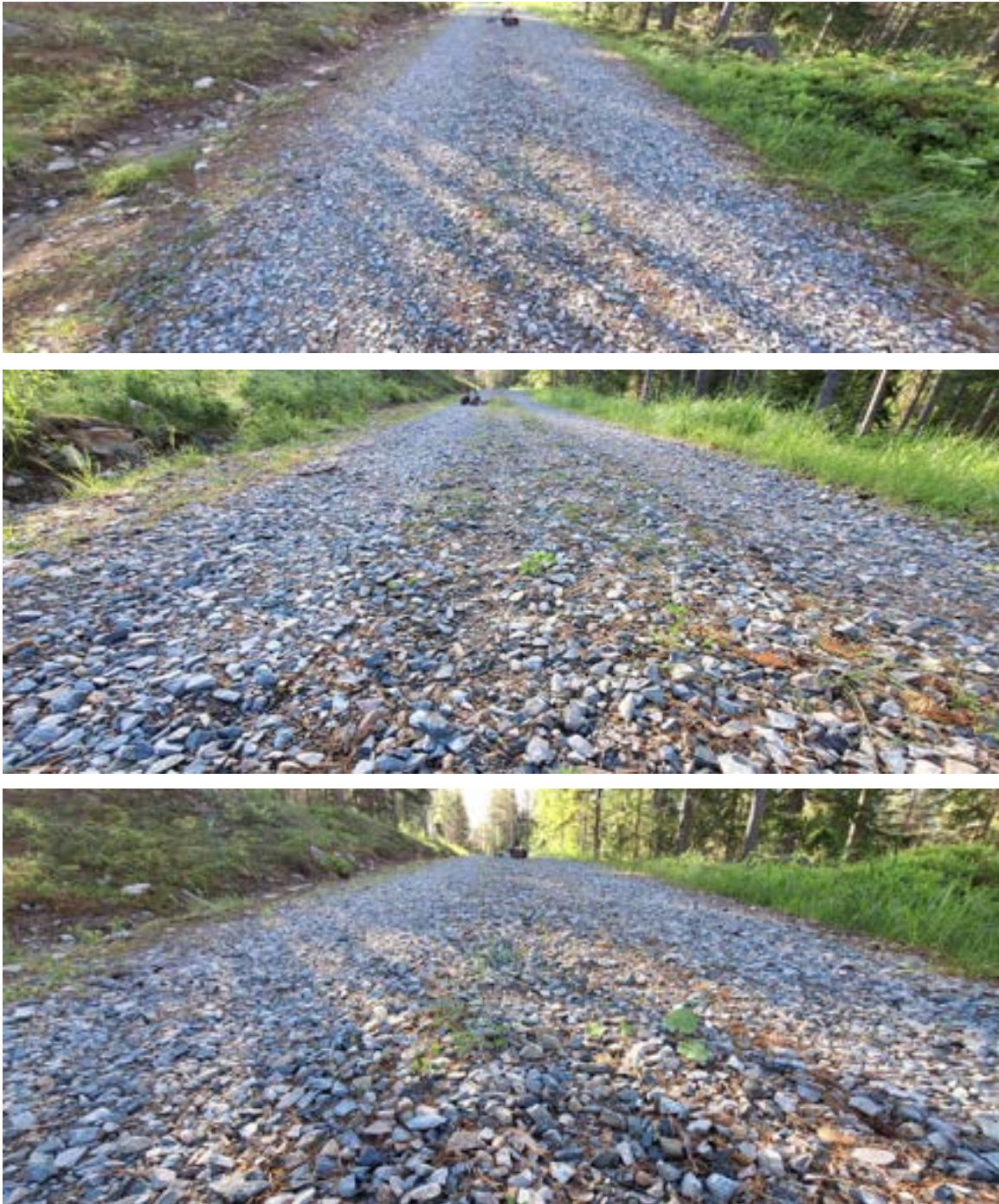
Figur 109: Okulär-inspektion av sträcka 3 (utan dränering) i Grängesberg. Foton: Andreas Waldemarson, VTI.
