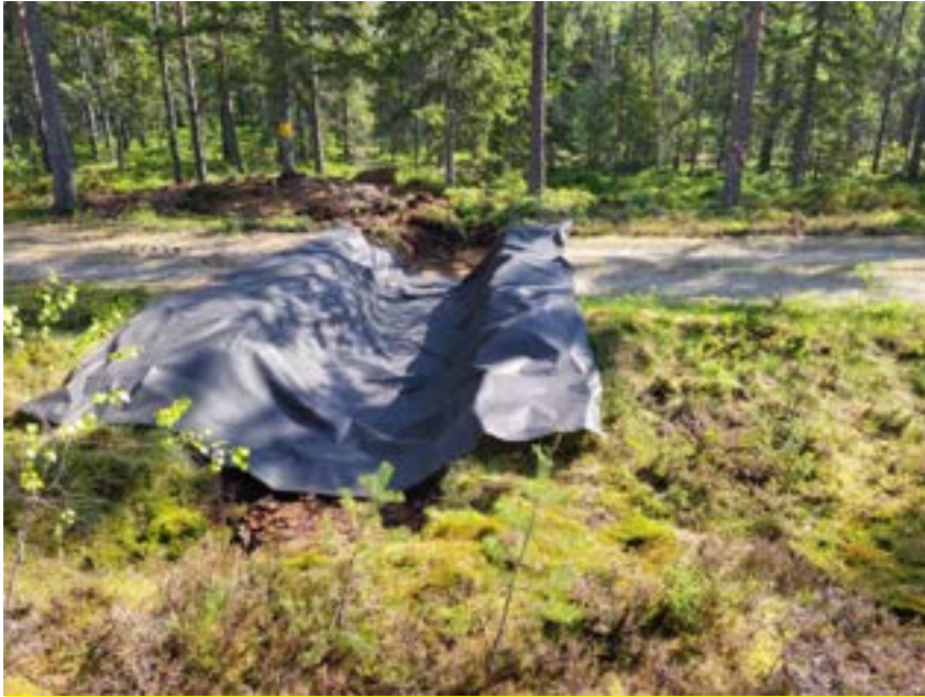
Figur 93. Bild på färdiggrävt dike som är täckt med geotextil. Foto: Johan Skoog, Kopparfors.
