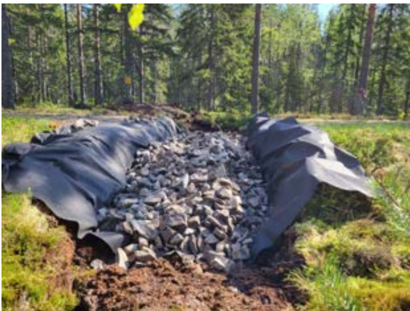
Figur 94. Bild på när makadamen är på plats. Foto: Johan Skoog, Kopparfors.
