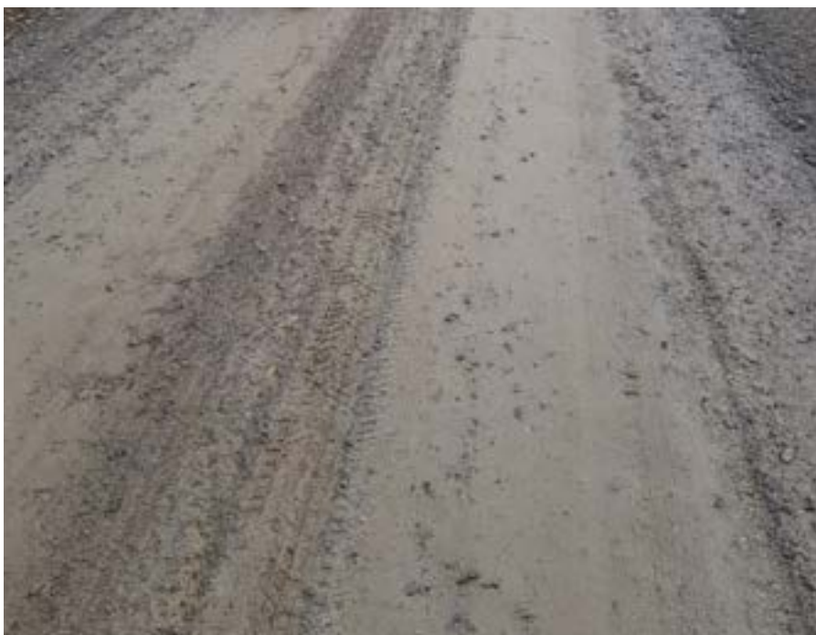
Figur 8: Vägsträckan med 0 % bombering som byggdes av SCA i Ånge. Foto: Tomas Johansson, SCA.
