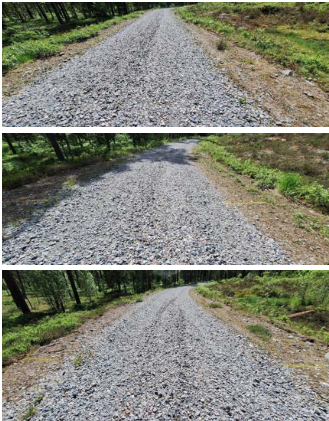
Figur 107: Okulär-inspektion av sträcka 1 (utan dränering) i Grängesberg. Foton: Andreas Waldemarson, VTI.
