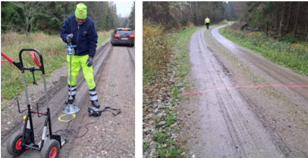
Figur 39: VTI mätningar efter byggnation före och efter väder- och trafikexponering av de vägsträckor som byggdes av Holmen. Foton: Dina Kuttah, VTI.
