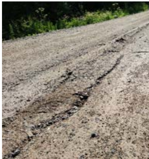
Figur 18: Bild till vänster visar sprickor ökade något mellan 140–165 meter och drog även till vänster i sträcka 3. Bild till höger visar ett hjulspår i vänster väggkant. Foton: Håkan Arvidsson, VTI.
