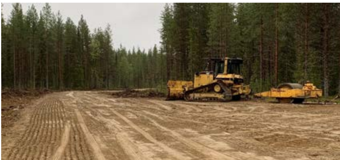
Figur 54: Bandtraktor med Ringvält, vältning av terrass ny väg. Foto: Mikael Bergqvist, Sveaskog.
