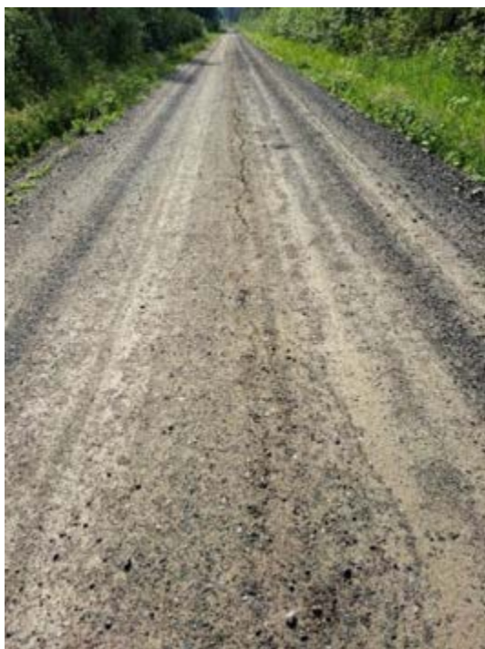
Figur 16: Bild till vänster visar en längsgående spricka i vägmitten av sträcka 3. Bild till höger visas en vag antydan till spricka, med små skador i höger hjulspår av sträcka 3. Foton: Håkan Arvidsson, VTI.
