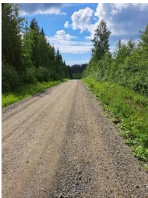
Figur 15: Vägsträcka 2 med 5% bombering vid slutbesiktningen. Foto: Håkan Arvidsson, VTI.
