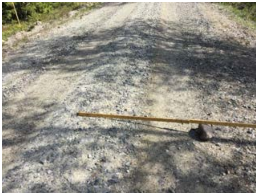
Figur 6: Vägsträckan med 10 % bombering som byggdes av SCA i Ånge. Foto: Tomas Johansson, SCA.
