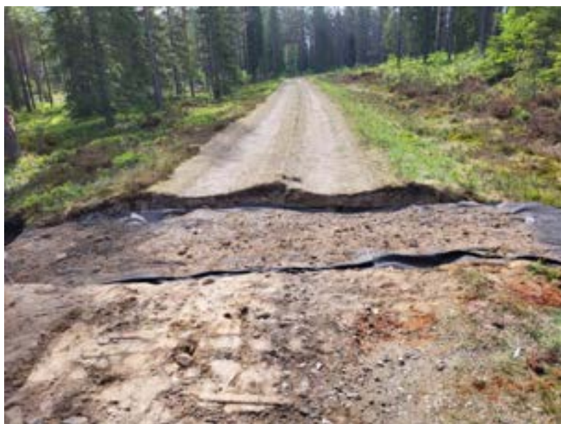
Figur 97. Toppades stenmadrassen och geotextilen med ett lager av finare fraktioner 0-32 mm. Foto: Johan Skoog, Kopparfors.
