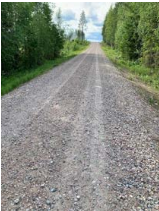
Figur 57 Teststräcka upprustning 1st överfart lastbi. Foto: Mikael Bergqvist, Sveaskog.
