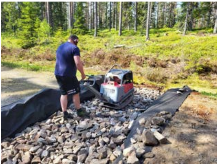
Figur 95. Packning av makadamen med markvibrator. Foto: Johan Skoog, Kopparfors.
