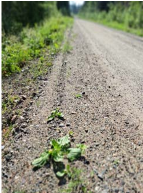
Figur 17: Bild till vänster visar löst grus i höger hjulspår av sträcka 3. Bild till höger visar mittspricka och spår av dubbelmontage vid väggkanten. Foton: Håkan Arvidsson, VTI.
