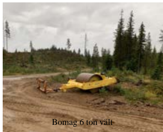
Figur 52: Vältning av befintligväg, Foton: Mikael Bergqvist, Sveaskog.
