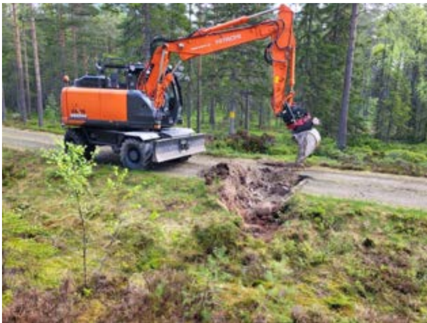
Figur 92: Bild på grävning av dike för stenmadrass. Foto: Johan Skoog, Kopparfors.
