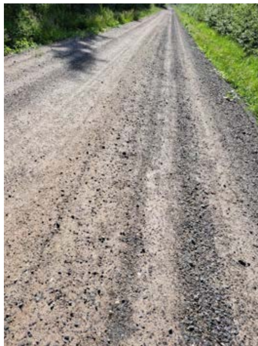
Figur 16: Bild till vänster visar en längsgående spricka i vägmitten av sträcka 3. Bild till höger visas en vag antydan till spricka, med små skador i höger hjulspår av sträcka 3. Foton: Håkan Arvidsson, VTI.
