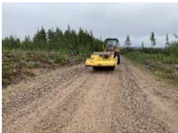
Figur 52: Vältning av befintligväg, Foton: Mikael Bergqvist, Sveaskog.
