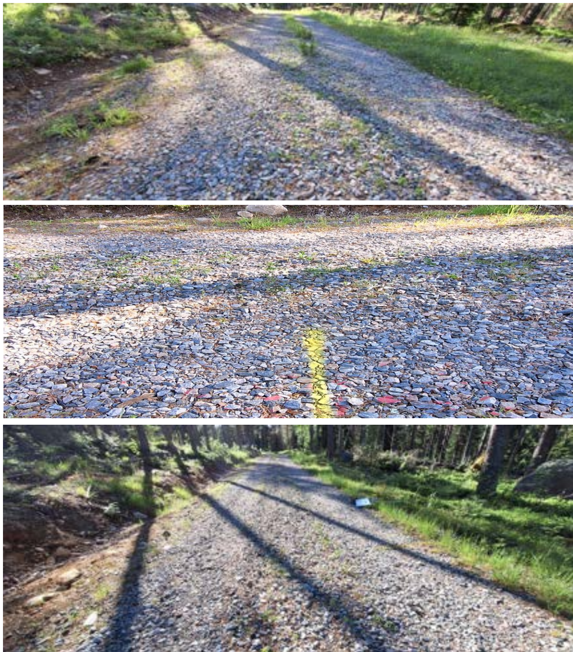
Figur 108: Okulär-inspektion av sträcka 3 (med dränering) i Grängesberg. Foton: Andreas Waldemarson, VTI.
