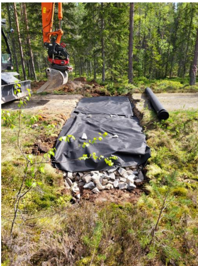
Figur 96. Makadamen täckt med geotextil. Foto: Johan Skoog, Kopparfors.
