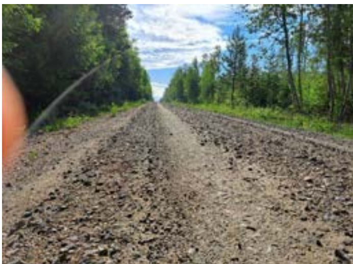
Figur 14: Löst grus i sträcka 1. Foto: Håkan Arvidsson, VTI.
