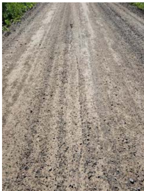
Figur 19: Svackan mellan 180–200 meter som visar större skador i sträcka 3, främst i höger hjulspår, och sprickor återkom efter svackan. Foto: Håkan Arvidsson, VTI.
