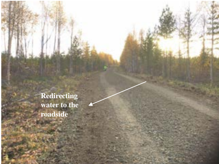
Figur 24: Den vattenavledningssystemen efter konstruktion. Foto: Tomas Johansson, SCA.
