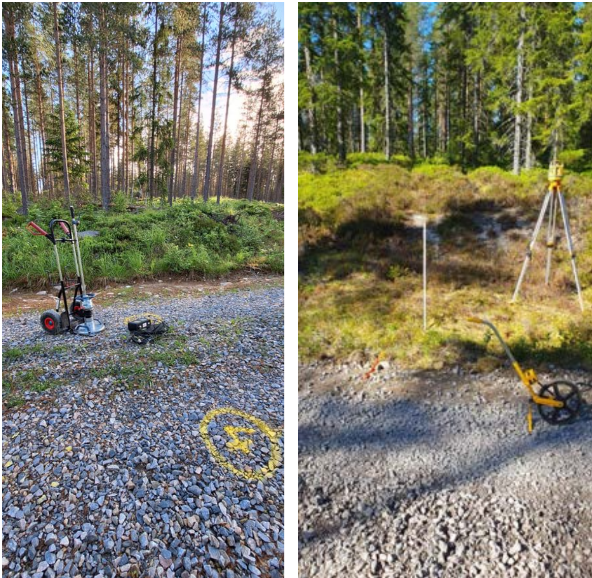
Figur 101: VTI-mätningar efter byggnation före och efter trafik- och väderpåverkan av de vägsträckor som Kopparfors byggt i Grängesberg. Foton: Andreas Waldemarson, VTI.
