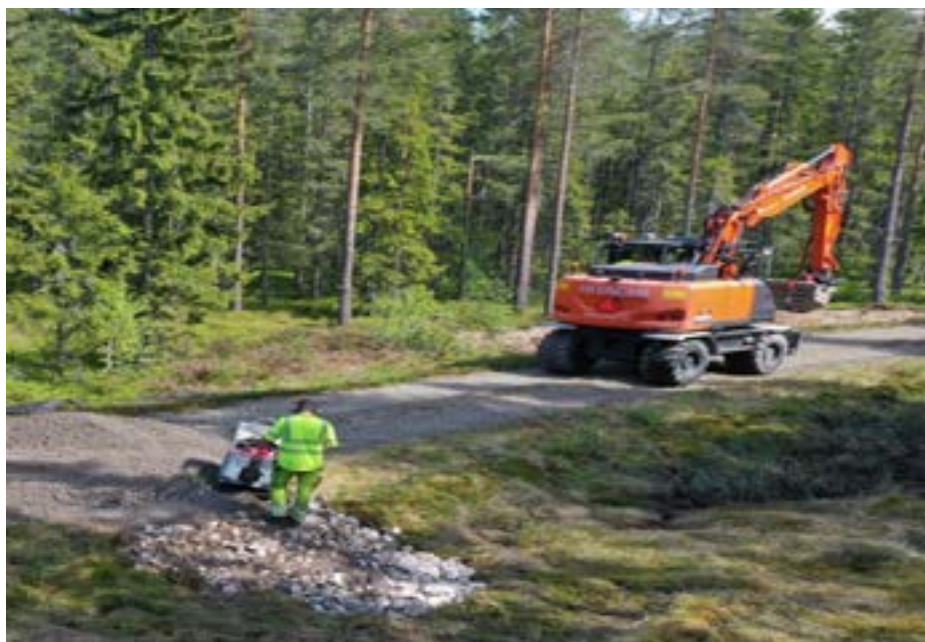
Figur 98. I slutet packades det översta lagret med markvibrator. Foto: Johan Persson, Kopparfors.
