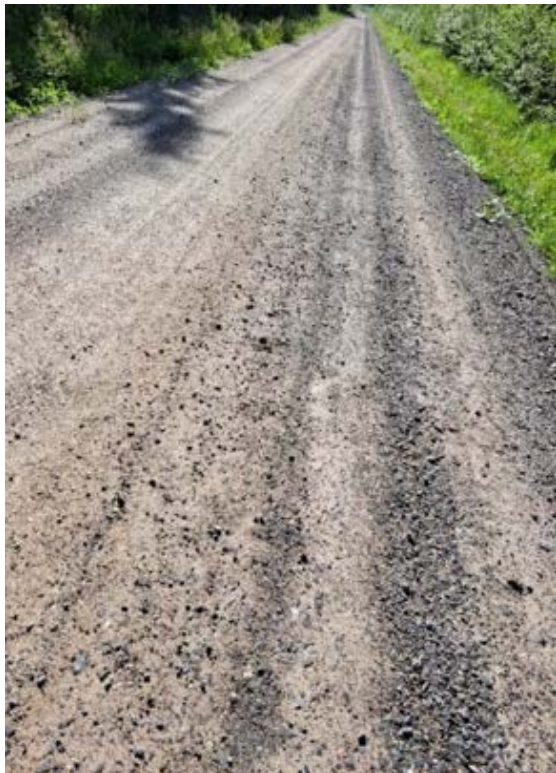
Figur 17: Bild till vänster visar löst grus i höger hjulspår av sträcka 3. Bild till höger visar mittspricka och spår av dubbelmontage vid väggkanten. Foton: Håkan Arvidsson, VTI.
