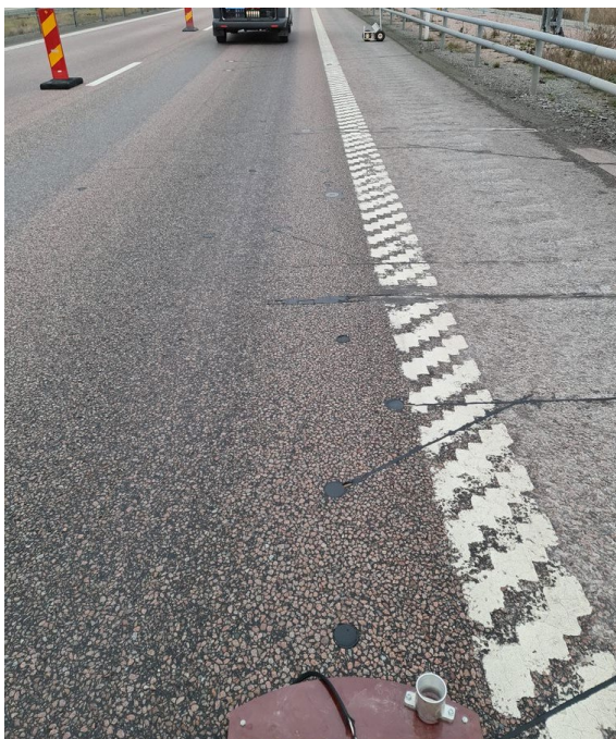
Figur 53. Körfält 1 med nedfrästa trådlösa sensorer DRS611 och skiss från Trafikverket över placeringen. Bild: A. Arvidsson respektive Trafikverket.
