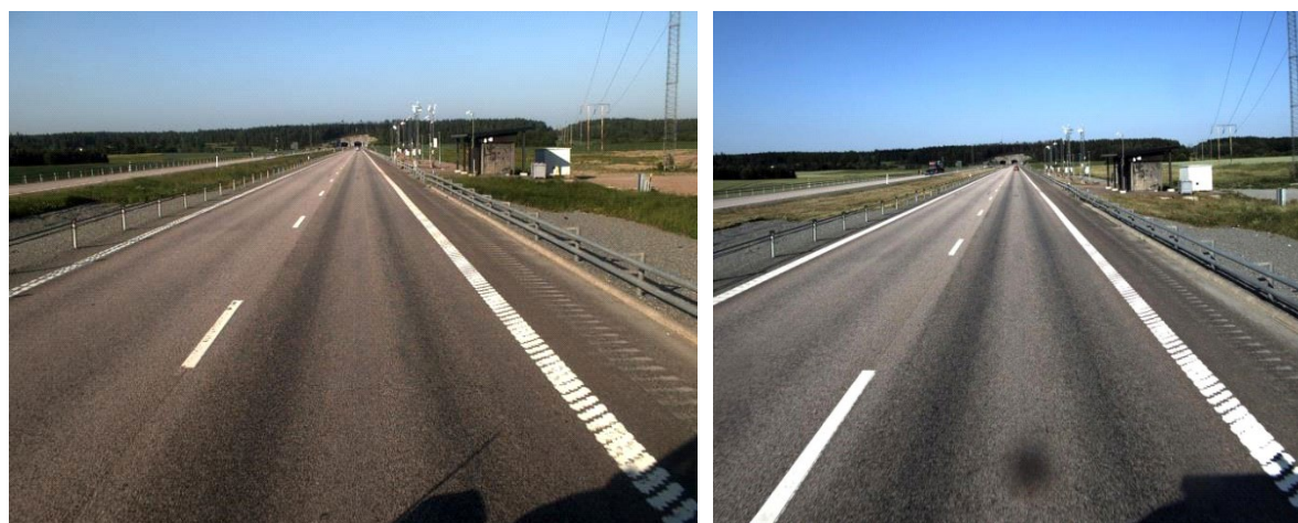
Figur 2. E18 vid Testsite E18 Sagån. Vänster bild från vägytemätningstillfället 2019-06-06 (Trafikverket, 2020) och höger bild från 2020-06-25 (Trafikverket, 2021).
