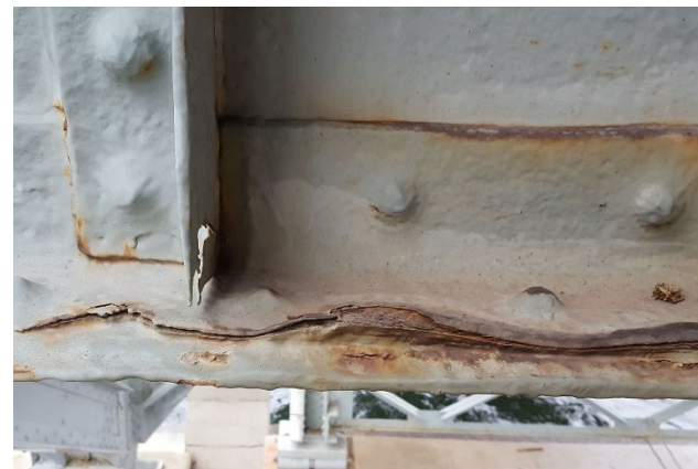
Spaltkorrosion.
