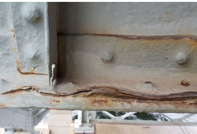
Spaltkorrosion.
