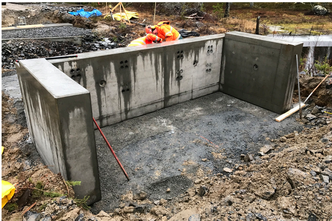
Montering av stöd, Eksjöbron. Foto: Tomas Johansson, SCA.
