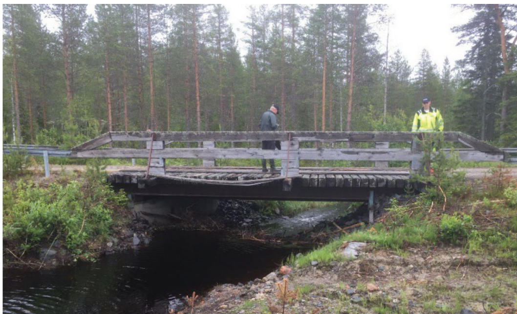
Figur 2. Inspektion av Eksjöbron som visade att både överbyggnad och underbyggnad behövde bytas ut. Det enda som sparades var ett L-stöd i betong som fick stå som erosionskydd till den nya bron. Foto: Mikael Bergqvist, Skogforsk
