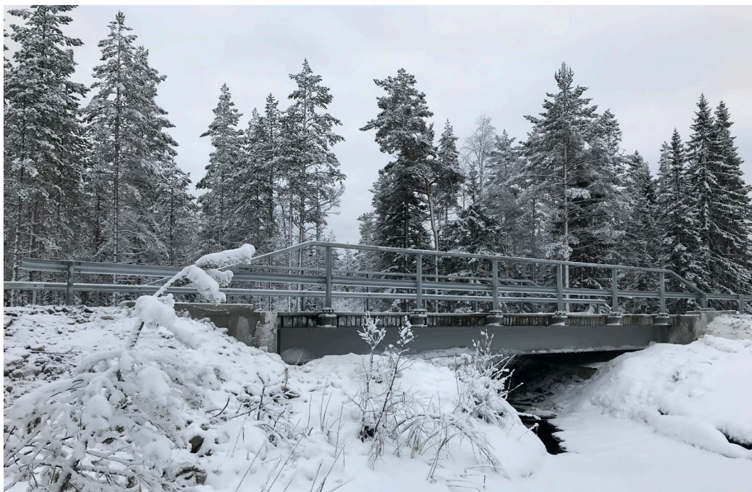
Figur 3. Ny bro i Eksjö enligt standardritning. En 12-meters stål balkbro med träfarbana och betongstöd, ritad av WSP inom parallellt projekt. Vägbanken höjdes cirka en meter intill bron. Upphandlingen gjordes enligt projektets metod och resulterade i en utförandeentreprenad som gick till PEAB. Foto: Tomas Johansson, SCA.
