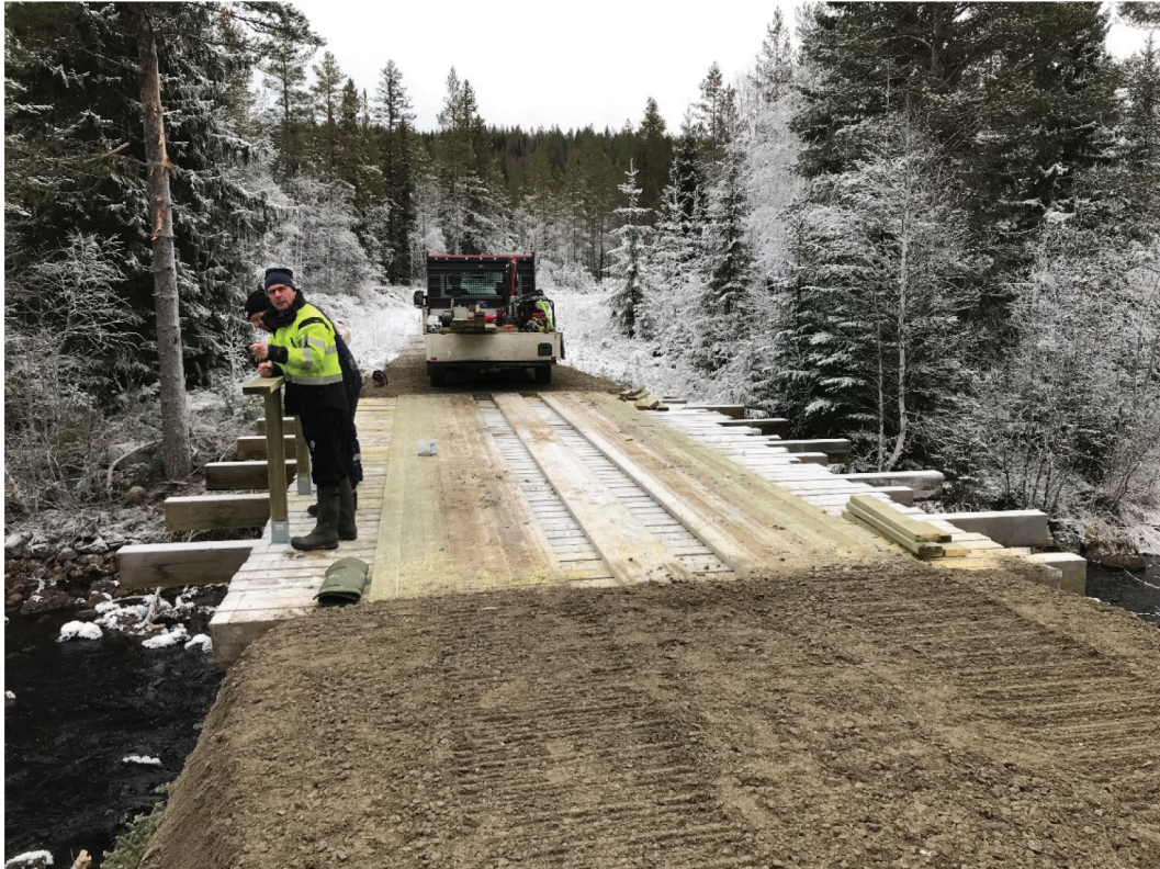
Nylagd träfarbana vid Återvänningsån. Foto: Tomas Johansson, SCA.
