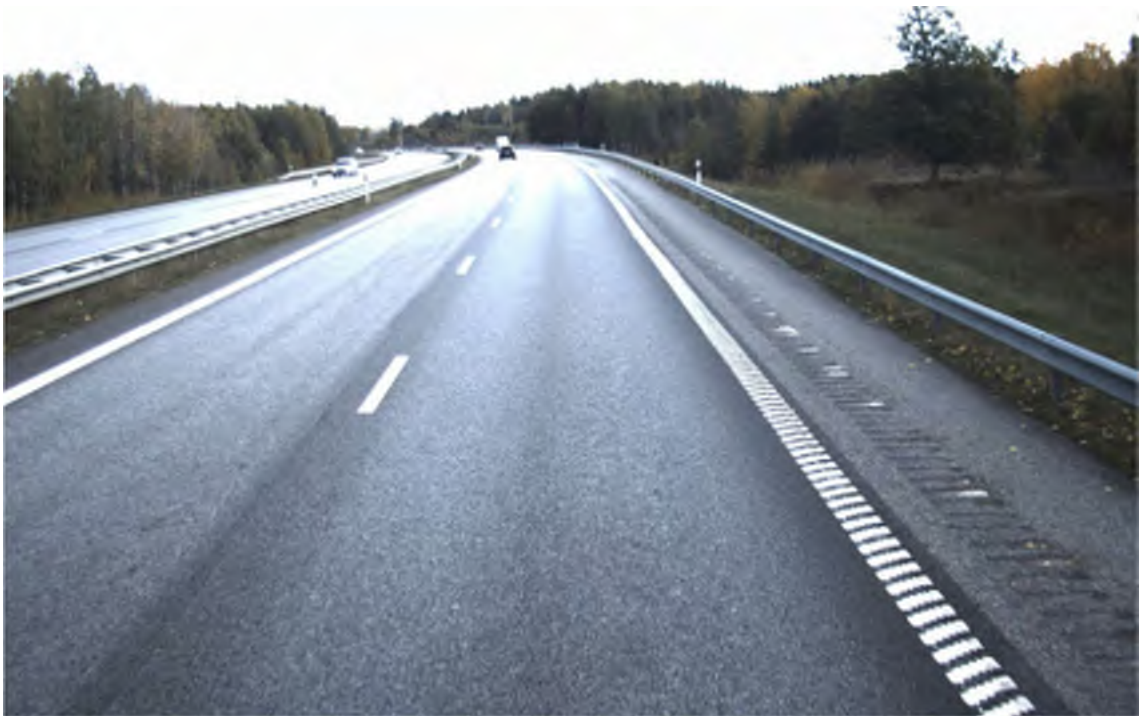
Figur 49. Foto sektion ca 21/000 för E20, K1, östergående riktning (TPL Marielund – TPL Härad), SCI_{300} \approx 105 \mu m .
