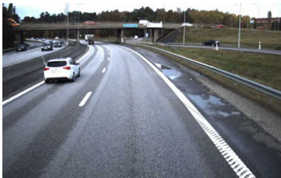
Figur 42. Foto sektion ca 17/000 för E4:an, K1, norrgående riktning förbi Jönköping (TPL Vaggeryd – TPL Gränna), SCI_{300} \approx 70 \mu\text{m} .
