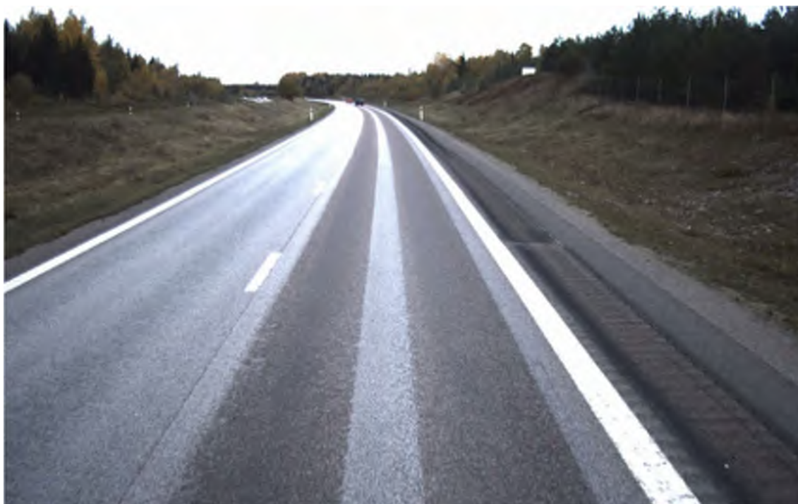
Figur 55. Foto sektion ca 37/000 för E4:an norrgående riktning förbi Uppsala, SCI_{300} \approx 45 \mu m .
