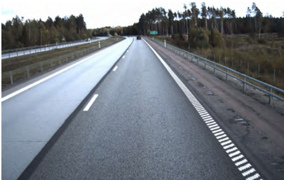
Figur 47. Foto sektion ca 12/500 för E20, K1, östergående riktning (TPL Marielund – TPL Härad), SCI_{300} \approx 6 \mu\text{m} .
