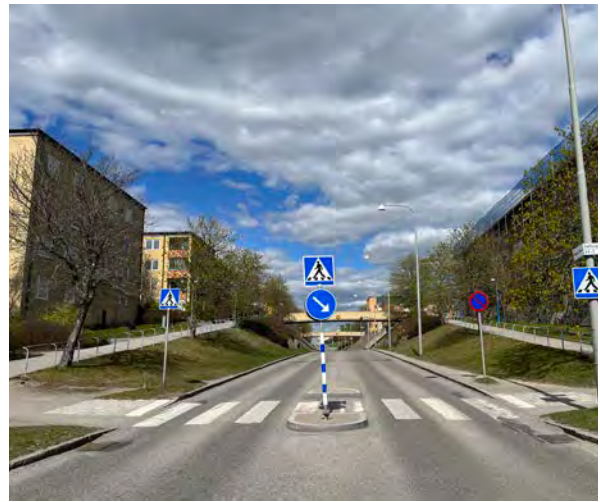
Trafiksepareringen är konsekvent genomförd, med olika nivåer för gående och bilar. Ryggraden i trafiknätet utgörs av nedsänkta matarleder.
