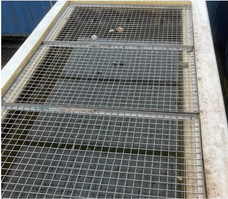
Figur 3.1: Finmaskigt stål nät ovanpå blandningsenheten slår isär finkornigt salt vilket förhindrar klumpbildning i saturator. (Consalt, 2023)
