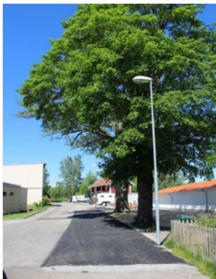
Figur 5: Systemlösning för dagvattenhantering vid Lilla Vallen, Växjö. Tv. Vägkroppen till höger närmast träden är uppbyggd enligt principen för dränasfalt. T.h. principskiss som visar uppbyggnad av dränasfalt (Sörelius m.fl., 2017).
