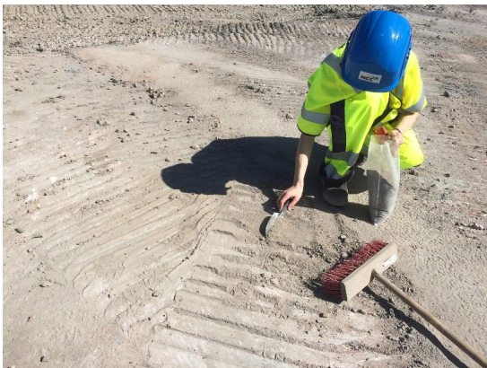
Figur B2.11. Provtagning av jordprover som antas ha sitt ursprung från schaktet. Dessa jordmassor antas fastna på lastbilshjul och därigenom spridas vidare till det lokala vägnätet.
