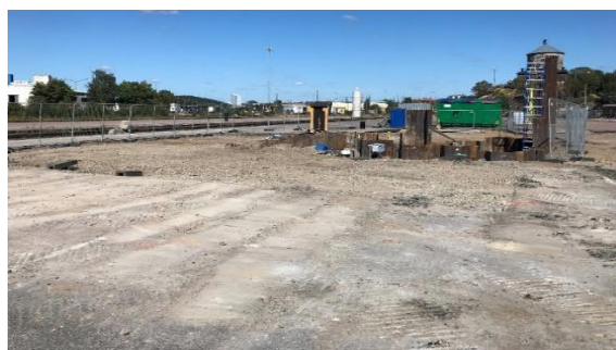
Figur B2.3. Schaktet på NCC:s entreprenadområde på Kruthusgatan.
