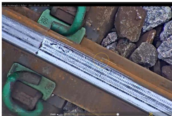
Figur 7. Ytskada observerad på ytterrälens fältsida skarv 5, till höger skadan dokumenterad via overheadkamer.
