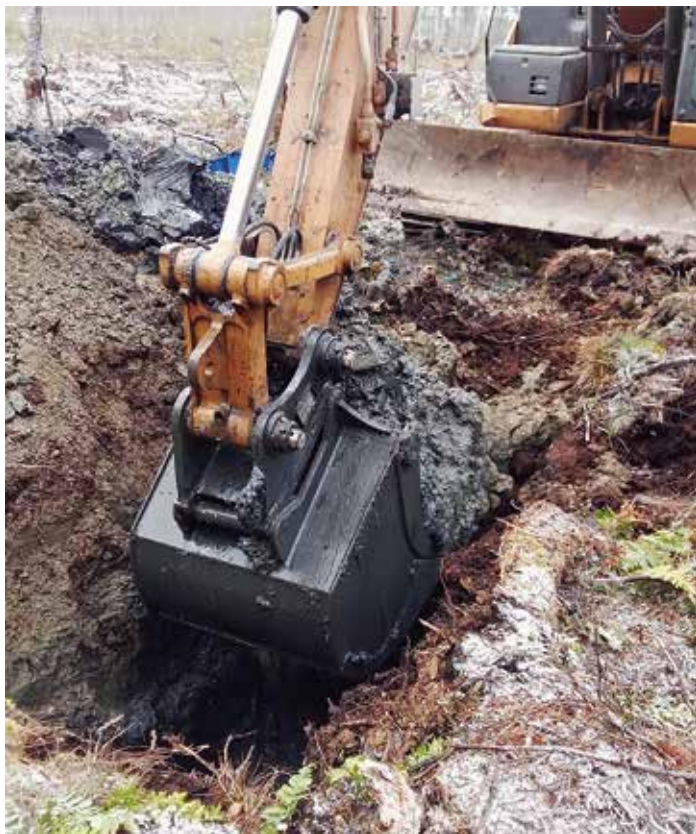
Figur 1: Foto från schaktning av svartbandad sulfidjord med torrskorpa av sulfatjord i Luleåområdet. (Johannes Pettersson, Swerock)
