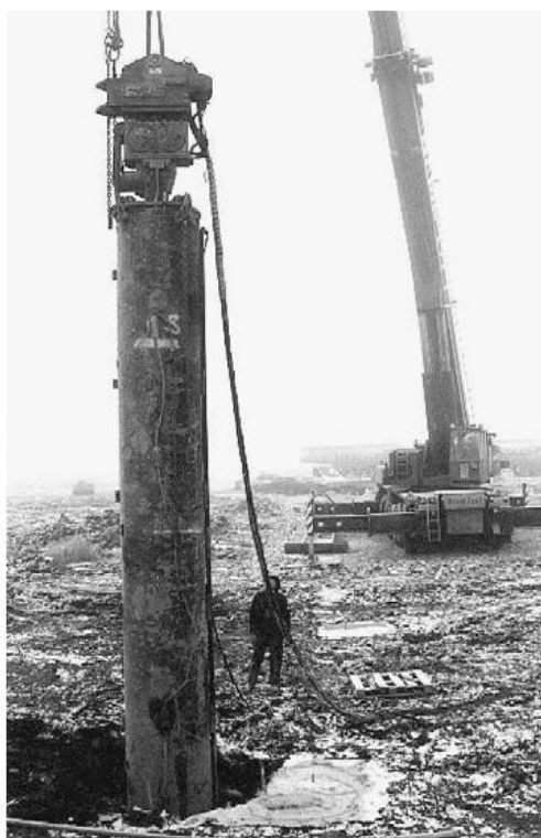
Figur 11: Upptagning av hel pelare. Foto Axelsson (2001).
