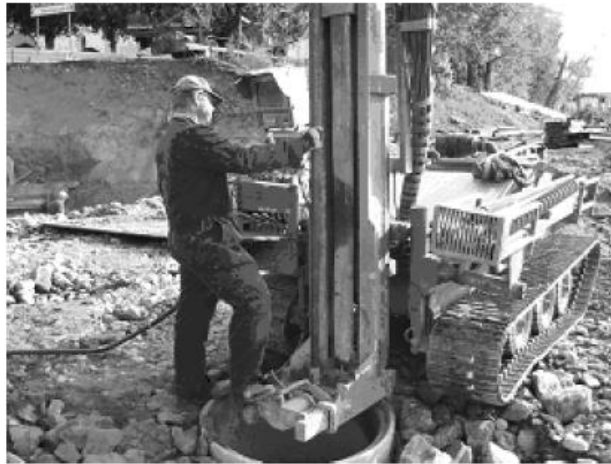
Figur 6: Kc-pelare testas med jb-totalsondering. En cementring är placerad ovanpå pelaren för att underlätta arbetet. Foto Jelisić och Nilsson (2005).
