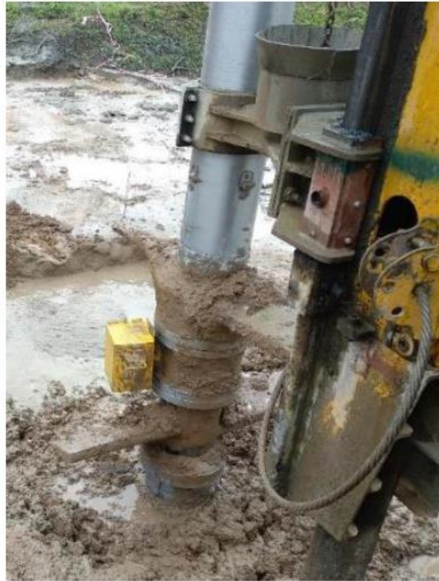
Figur 9: Materialprov kan tas i kc-pelare med metoden wet grab. Foto Yohannes och Daramalinggam (2019(a)).
