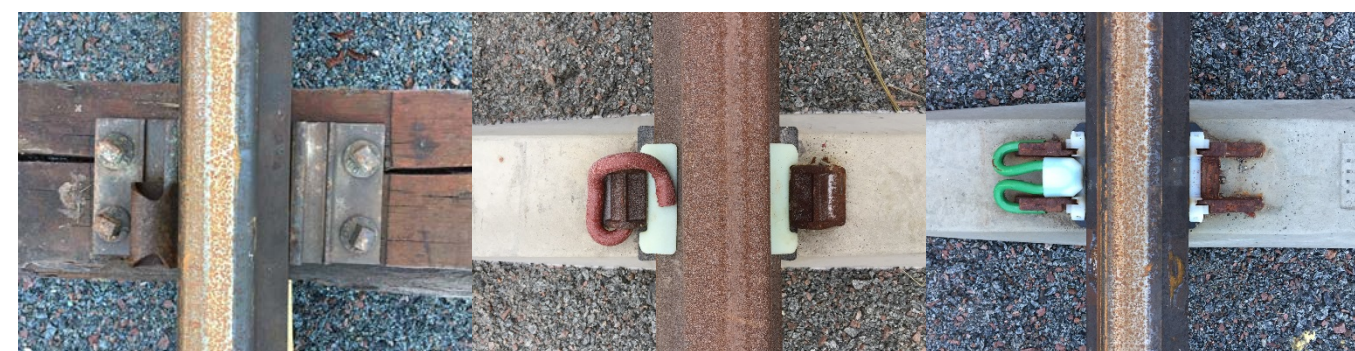
Figur 1 Tre olika typer av befästningar, Hayback, e-clip och fast clip.
