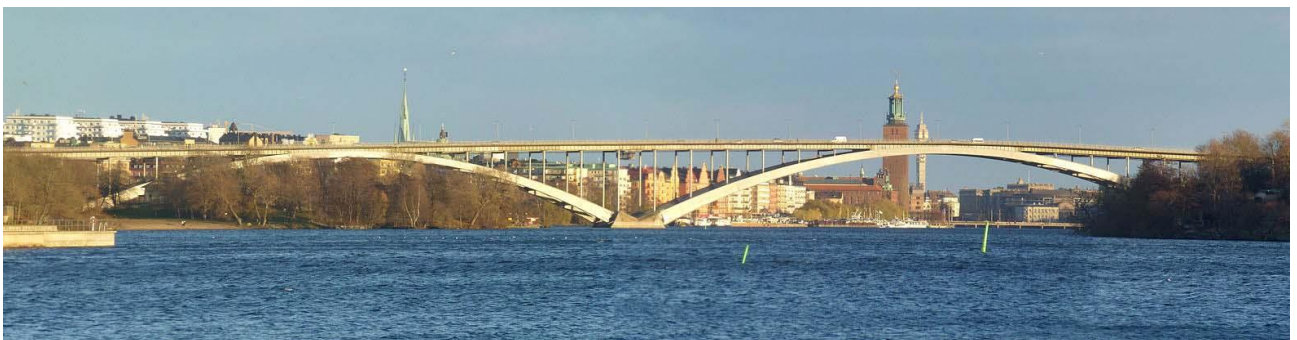
Figur 1. Västerbron i Stockholm mellan Kungsholmen och Södermalm.
